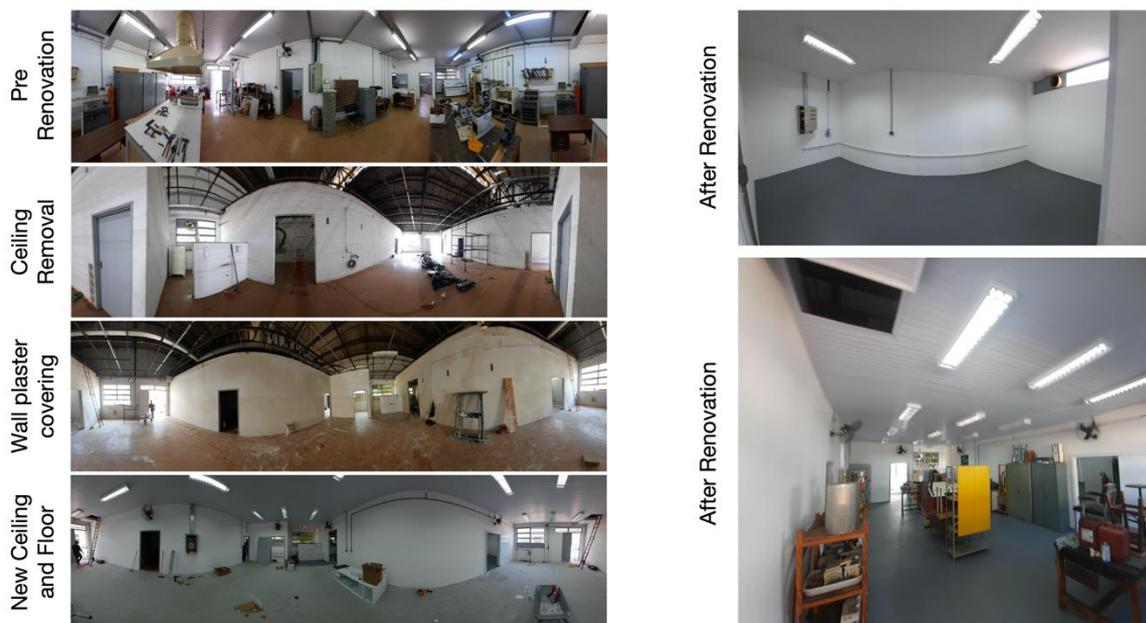
Figura 8) Processo de renovação do laboratório de vácuo.
