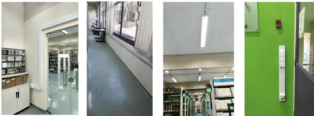
*Figura 4: Novos canaletas de alumínio distribuídas por toda BIF, lâmpadas tubulares de LED e a instalação de um conjunto de interruptores para acendimento de todas as lâmpadas da BIF.*
