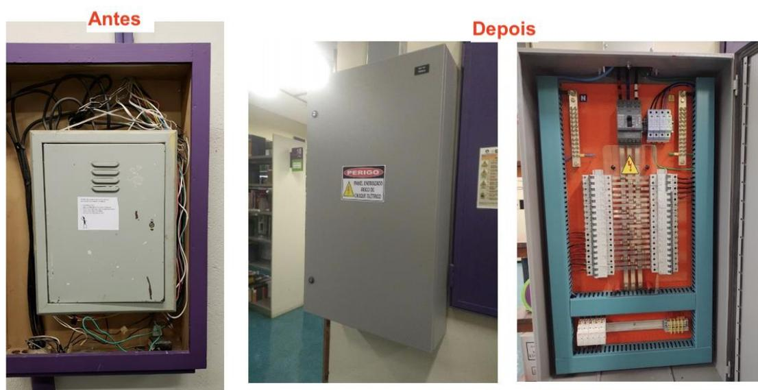
*Figura 3: Substituição dos painéis de distribuição madeira antigos por painéis novos com disjuntores.*
